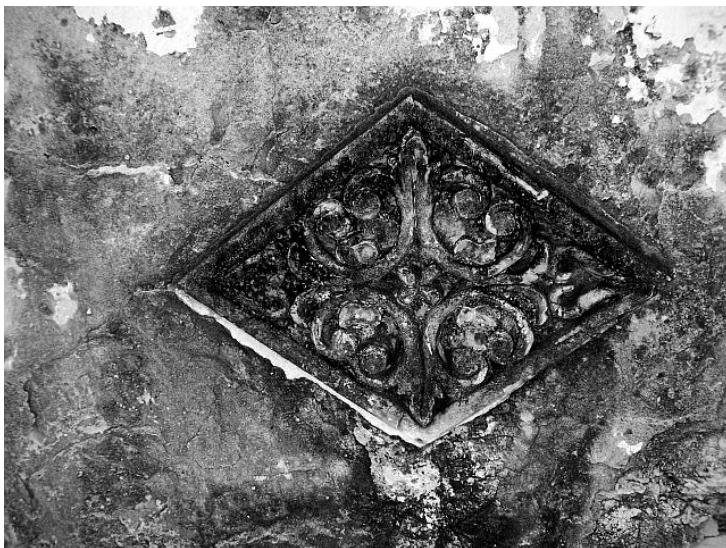
Imagem 4: Detalhe na parte inferior das ruínas do Hospital de Laranjeiras
