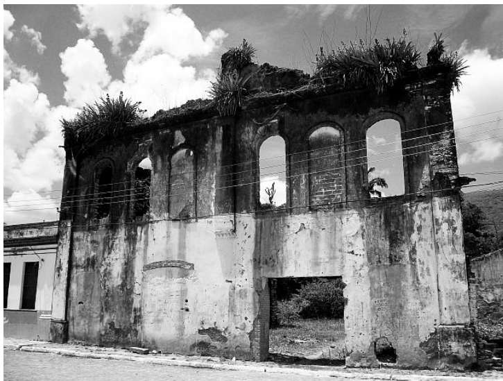
Imagem 1: Ruínas do Teatro São Pedro (parte externa)
