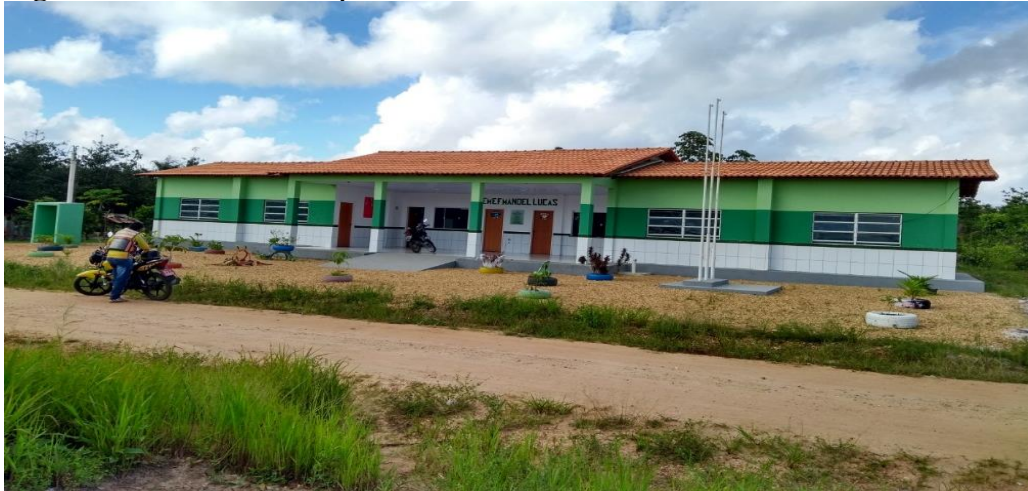
Figura 5 – Escola Municipal de Ensino Fundamental Manoel Lucas
