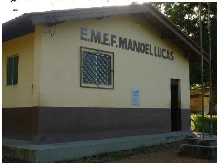
Figura 4 – Escola Municipal de Ensino Fundamental Manoel Lucas
