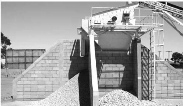
h) Lançamento do material britado com peneiramento - diferentes faixas granulométricas
