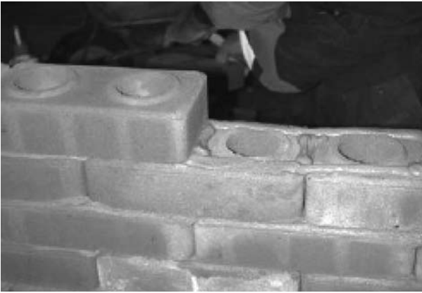
Figura 1a) Tijolos modulares de solo-RCD-cimento prensados manualmente.
