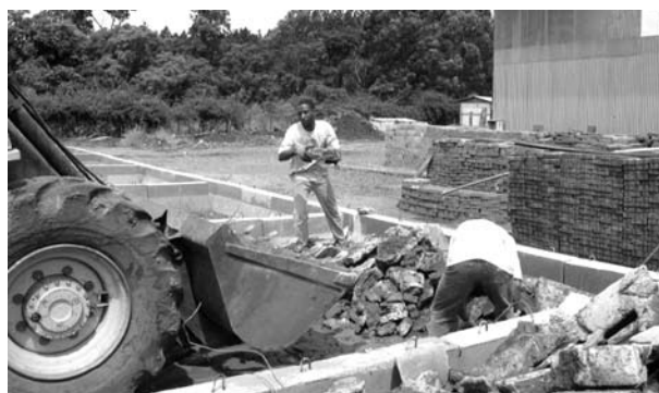
c) Detalhe das baias de material triado
