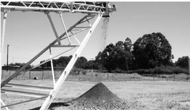
g) Lançamento do material britado sem peneiramento - "Bica Corrida"
