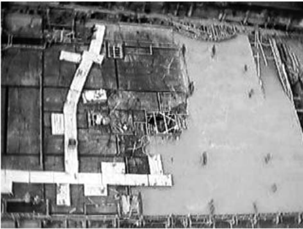
Figura 4: Vista superior da moldagem de um pavimento, visualizando-se parte do pavimento concretado e disposição dos caminhos para início da moldagem da outra parte
