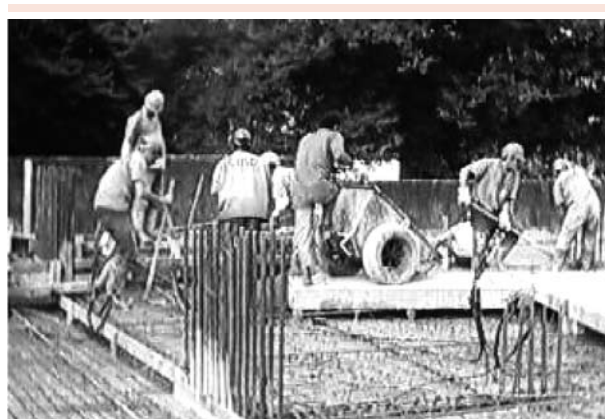
Figura 3: Detalhe da moldagem do pavimento, visualizando-se as jericas sobre os caminhos de madeira utilizados para avanço da concretagem
