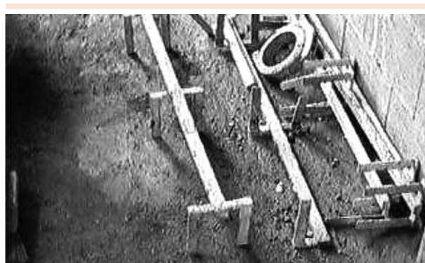
Figura 2: Mestras metálicas utilizadas em concretagem
