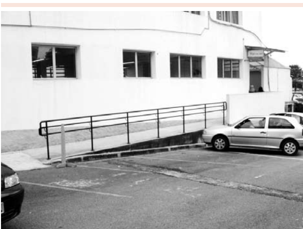
Foto 1: Corrimão do prédio “A”
