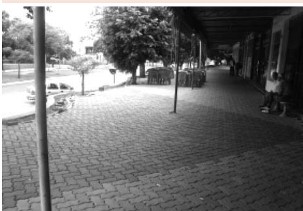
Figura 3: Execução de calçada em Ilha Solteira - SP
