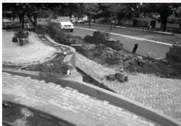
Figura 4: Execução de calçada em Ilha Solteira - SP
