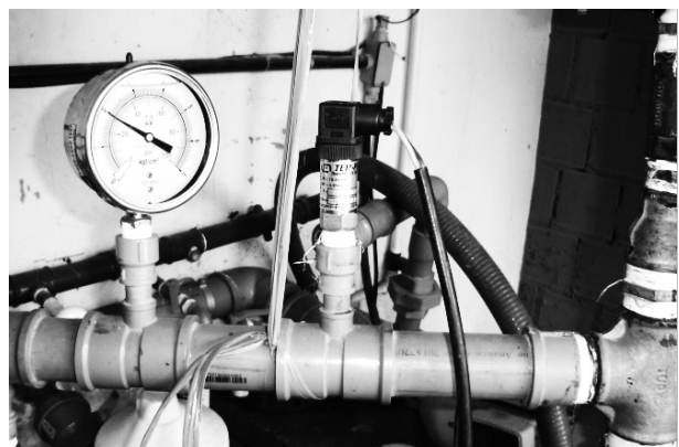
Figura 4: Manômetro e Transmissor de pressão
