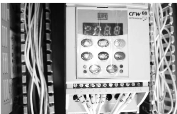
Figura 6: Inversor c/ velocidade de 208,8 rpm
