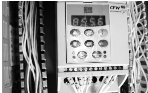
Figura 7: Inversor indicando velocidade de 855,6 rpm
