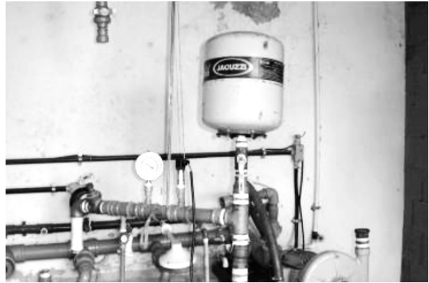
Figura 3: Tanque pulmão
