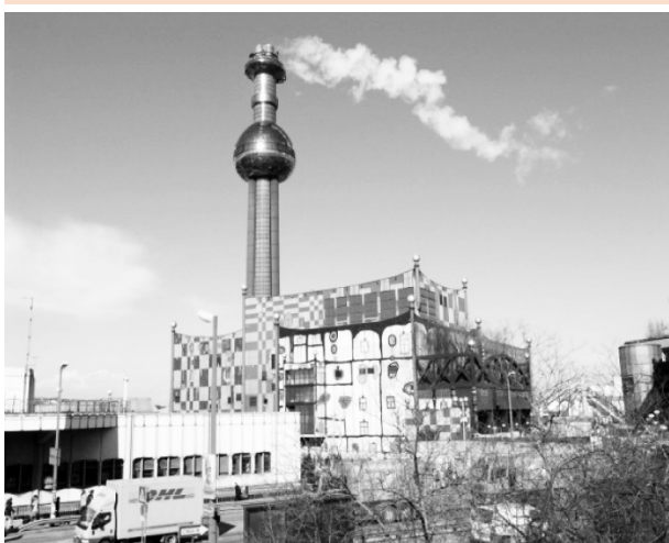
Figura 2b: Incinerador instalados em Viena
