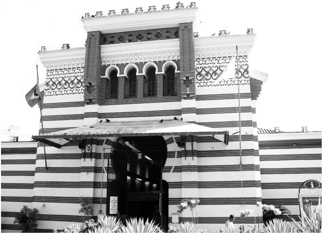
Figura 4: Mercado Municipal de Campinas em 2009. A disposição do corpo central do mercado e a sua relação com os corpos laterais, a disposição dos boxes, assim como as soluções para as coberturas, correspondem aos planos tipos sugeridos por Louis Cloquet para um mercado municipal central no seu tratado de arquitetura. O edifício foi erguido em estilo neomourisco, com arcos em forma de ferradura, ameias arrematando as paredes externas e portadas com motivos árabes. Os ornamentos mouriscos para o edifício do mercado evocam a atividade mercantil, própria dos povos árabes, atitude comum à cultura arquitetônica eclética do século XIX e princípios do século XX
