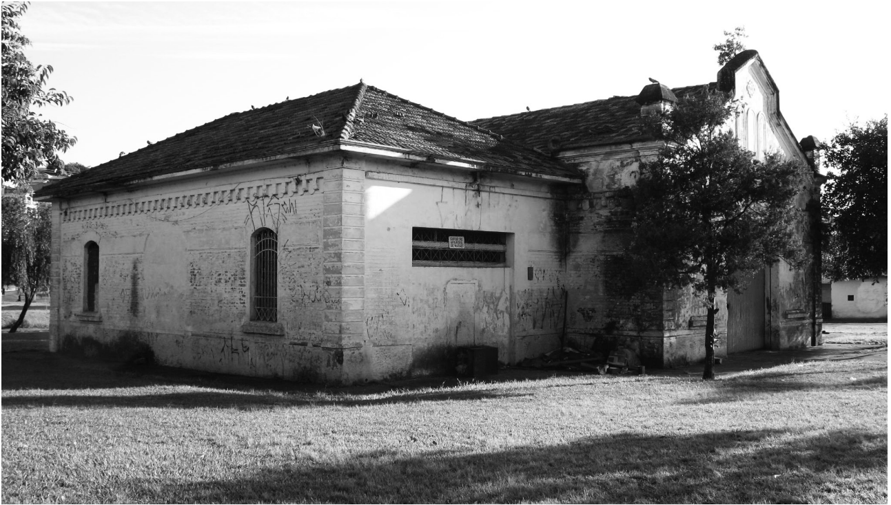
Figura 2: Matadouro Municipal de Bragança Paulista em 2009. O partido adotado neste edifício segue as mesmas características tipológicas do Matadouro Municipal de Campinas, tendo o edifício sido adaptado para uma pequena cidade, como recomendava os tratados de arquitetura do século XIX. Atualmente, o edifício, localizado nas margens de um córrego, foi transformado em casa de cultura. Apesar da destinação de um novo uso para este patrimônio e da sua preservação, o seu estado de conservação é precário
