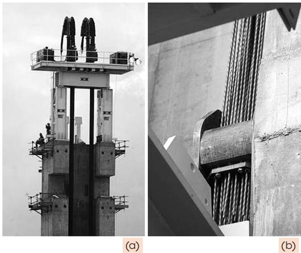
**Figura 40:** Vista da construção do *Arizona Cardinals*, 2007, projeto do arquiteto Peter Eisenman. Torre de apoio em (a), e detalhe dos cabos para içar a treliça de apoio em (b)
