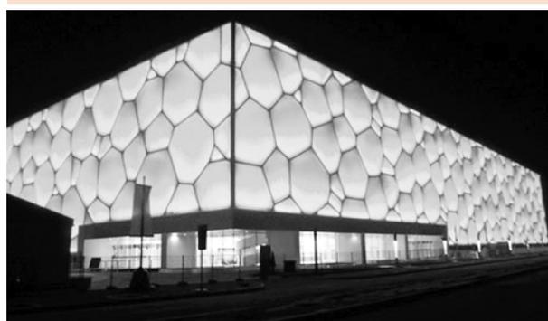
Figura 4: O sistema em parede dupla de ETFE no Cubo Aquático, no período noturno, efeito de uma caixa azul brilhante pela instalação de *Lights Emitting Diode* (LED), projetado pela empresa Herzog & De Meuron Architekten
