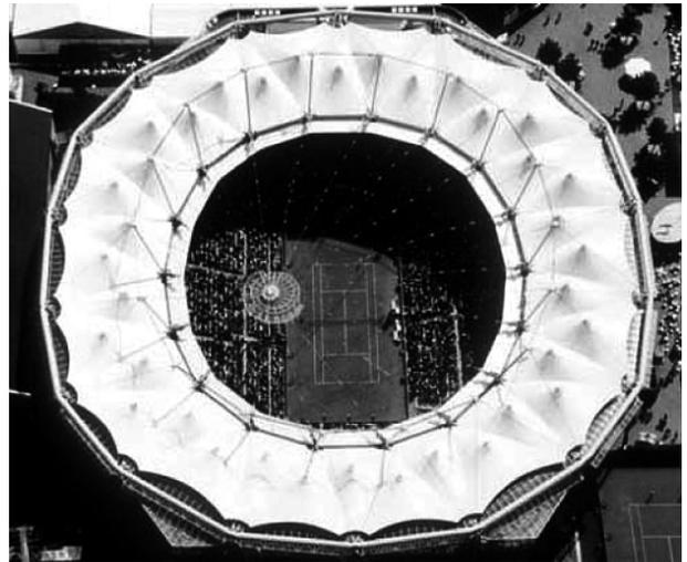
**Figura 19: Vista superior do Estádio Rothenbaum, em Hamburgo, na posição da membrana aberta - Rothenbaum Tennis Court, desenvolvido pelo escritório Architen Landrell**
