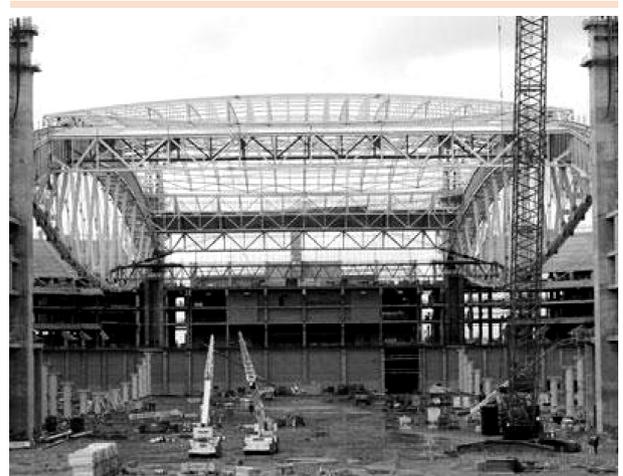
**Figura 38: Fase de construção do Arizona Cardinals, 2007, nota-se as treliças de apoio da cobertura retrátil e as torres de apoio, projeto do arquiteto Peter Eisenman**
