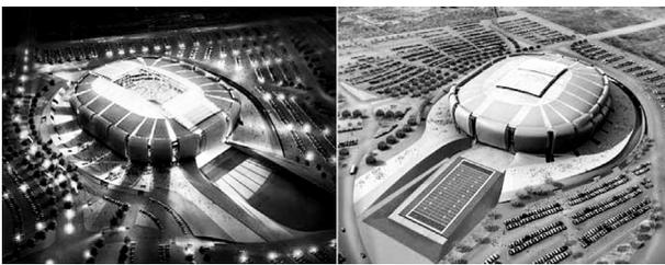
**Figura 36: Imagem do projeto de abertura da cobertura retrátil e detalhe do campo retrátil/deslizante, do Arizona Cardinals, 2007, projeto do arquiteto renomado, Peter Eisenman**
