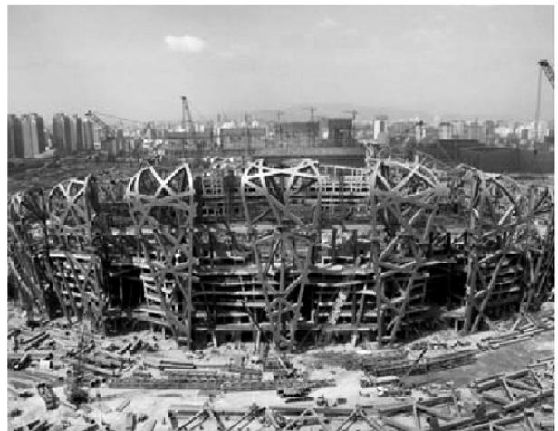
**Figura 3: Visão frontal dos semipórticos projetados por Herzog e De Meuron Architekto**
