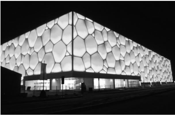
**Figura 13: Sistema em parede dupla de ETFE no Cubo Aquático, no período noturno, efeito de uma caixa azul brilhante pela instalação de light-emitting diodes (LED)**
