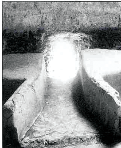
Figura 5 - Sistema de abastecimento de água construído pelos romanos (CEMBUREAU, 1995)
