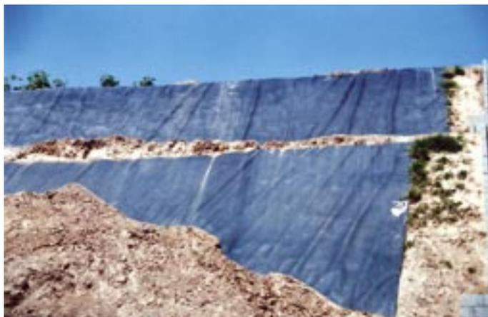
**Figura 2** – Geomembranas de polietileno de alta densidade fixadas no talude.
