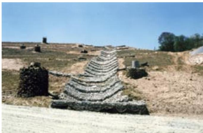
**Figura 3** – Vista do sistema de enrocamento de brita e dos drenos verticais.
