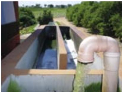
**Figura 7 - Tanque de contato de cloro.**
