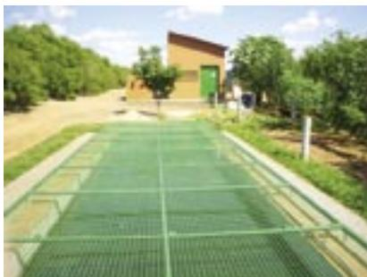
**Figura 5 – Tanque de piscicultura alimentado com efluente da lagoa facultativa.**
