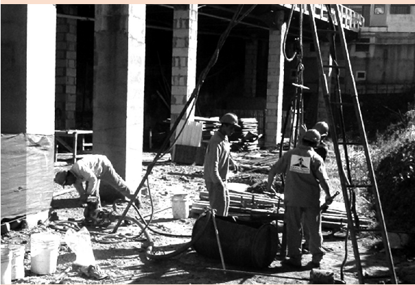
Fotografia 3: Escavação por meio de lavagem
