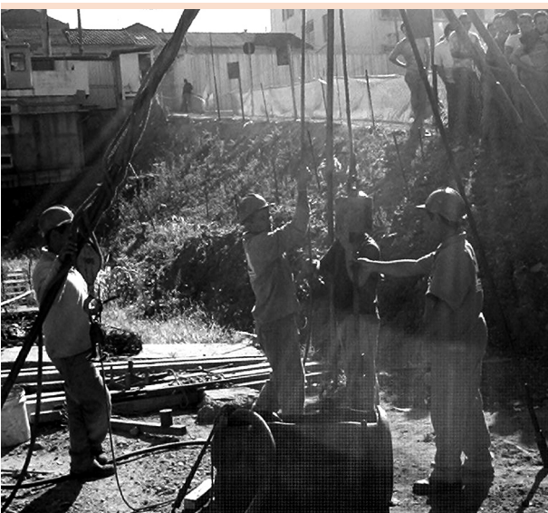
Fotografia 4: Cravação do amostrador
