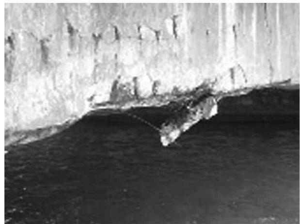
**Foto 2: Desprendimiento del Recubrimiento inferior por corrosión de la barra.**
