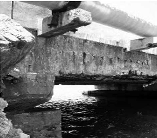
**Foto 4: Corrosión generalizada de todos los elementos**
