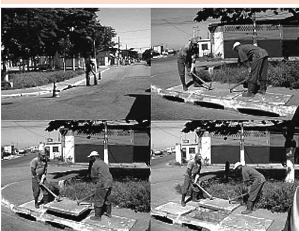
Figura 1: Retirada da tampa de concreto da boca-de-lobo
