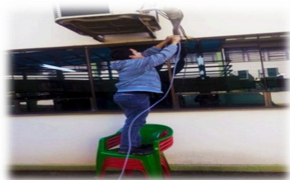
Figura 1 – Instalação da mangueira de nível
