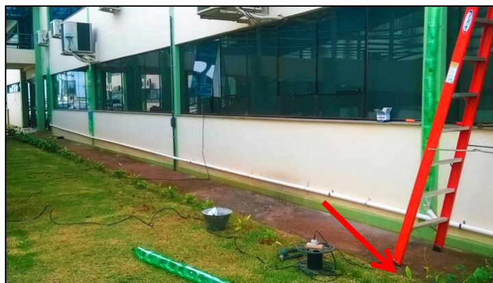
Figura 3– Fixação das tubulações verticais e conexões, com a tubulação horizontal.
