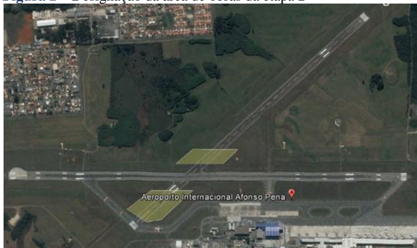
Figura 2 – Designação da área de obras da etapa 2
